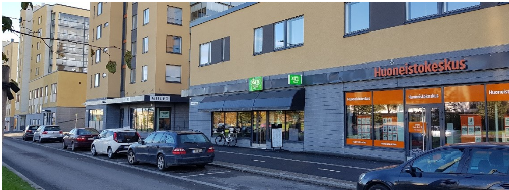
Kivijalkapalveluiden nauha jatkuu myös uusissa asuinrakennuksissa
